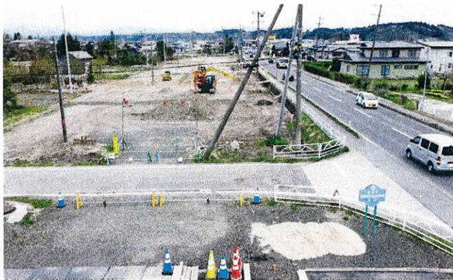
令和4年4月（市道河辺小学校線付近） 車線切替前
