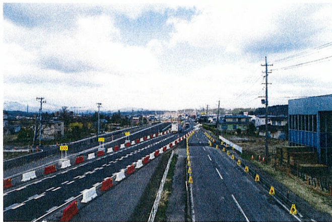
令和5年3月（市道河辺小学校線付近） 車線切替前
